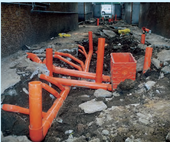
下水道排水配管 Sewer Engineering
