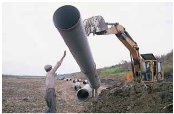
農田灌溉工程
